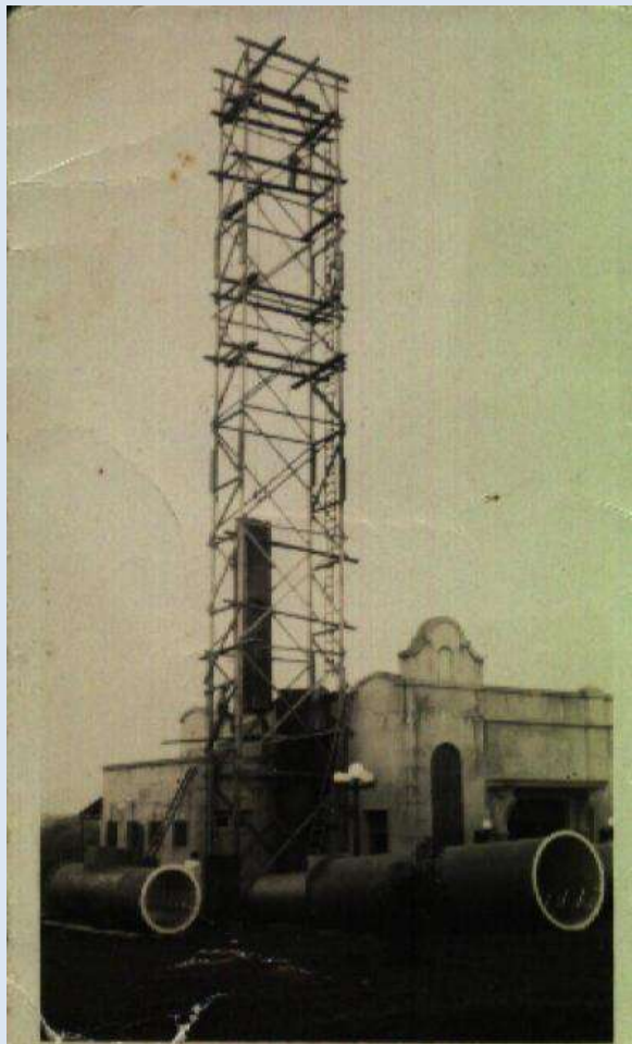
CONSTRUCCIÓN DE LA CHIMENEA DE LA USINA DE AGUAS CORRIENTES
